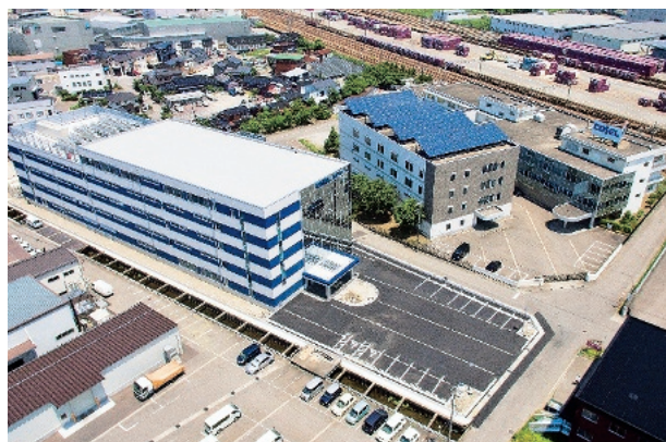
社屋：本社・R&Dセンター
