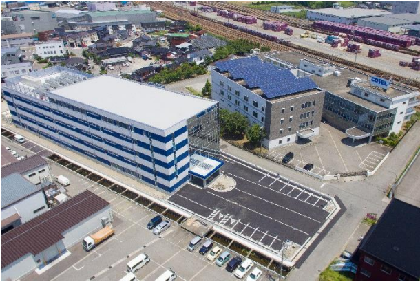
社屋:本社・R&Dセンター
