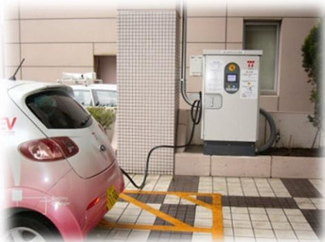
EV車用充電器
