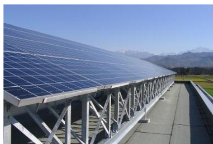
立山工場 太陽光発電装置
