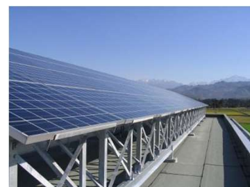
立山工場 太陽光発電装置
