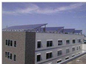
本社新社屋の太陽光発電パネル
