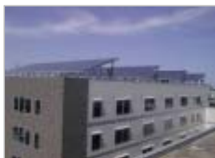
本社新社屋の太陽光発電パネル
