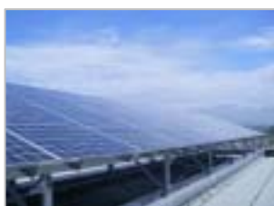
立山工場の太陽光発電パネル
