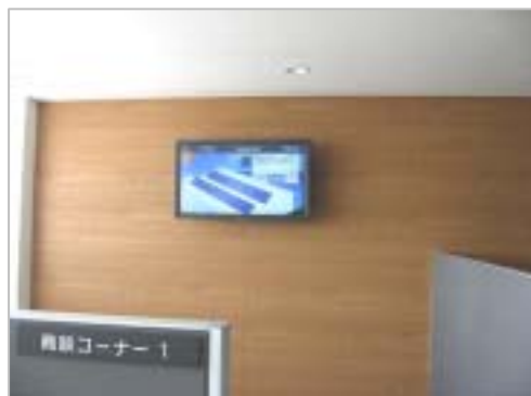
立山工場商談コーナーに設置された太陽光発電電量表示パネル
