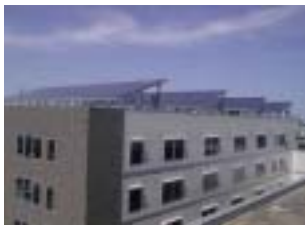
本社新社屋の太陽光発電パネル
