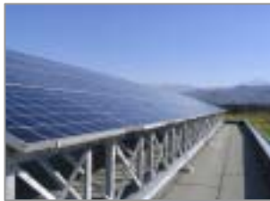
立山工場の太陽光発電パネル
