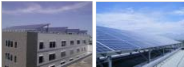
本社新社屋の太陽光発電パネル 立山工場の太陽光発電パネル
