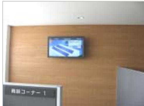
立山工場商談コーナーに設置された太陽光発電電量表示パネル
