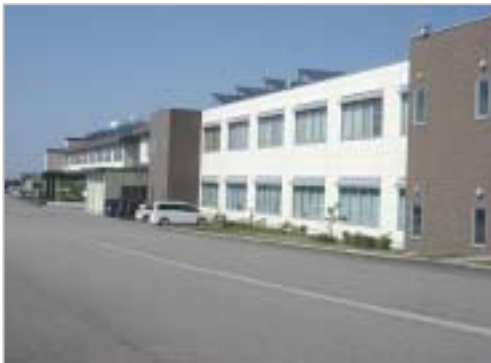
立山工場屋上に設置された太陽光発電装置
